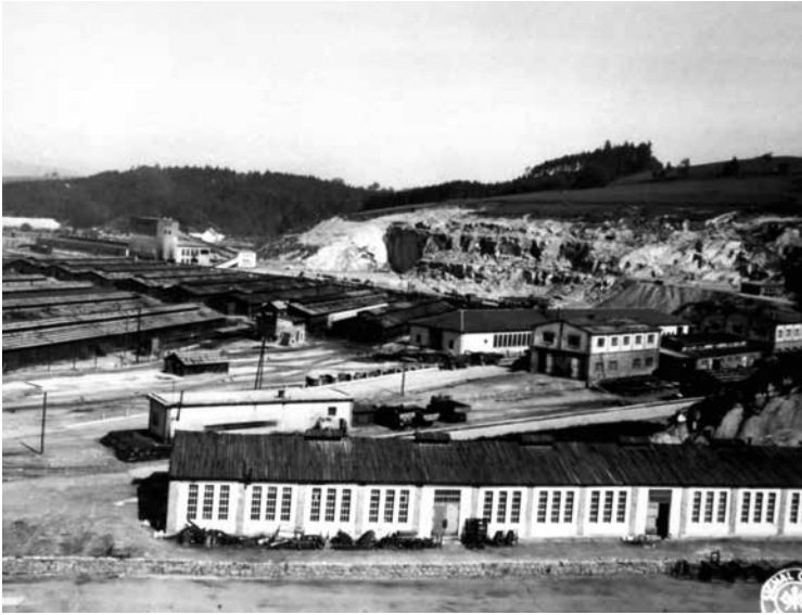
Abb. 4: Das ehemalige Außenlager Gusen nach der Befreiung; zu sehen sind im Vordergrund u.a. Werkstattbaracken sowie im Hintergrund Steinbrecher und Steinbruchkante; links sind die Messerschmitt- bzw. Steyr-Daimler-Puch-Baracken zu erkennen, Fotograf: Eugene S. Cohen, US Signal Corps, Fotoarchiv der KZ-Gedenkstätte Mauthausen/Collection USHMM
